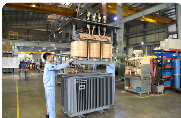
Đổ dầu máy biến áp
